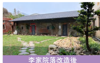
李家院落改造後
