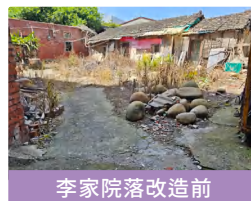
李家院落改造前
